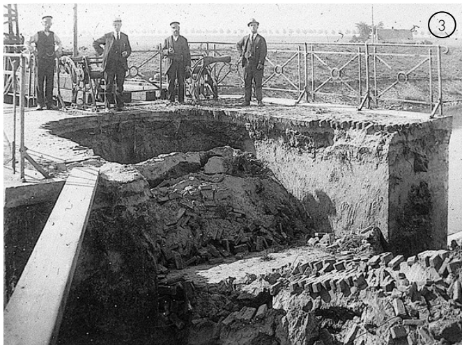
De instorting aan de noordkant.
